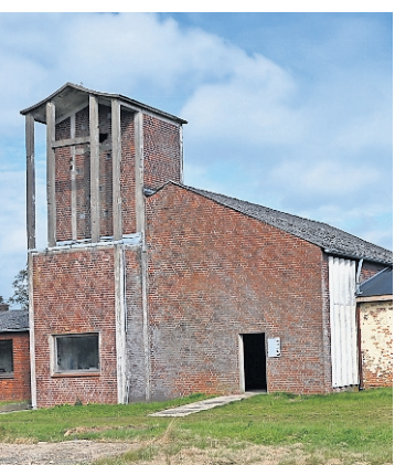
Mit der ehemaligen katholischen Kirche auf dem Gelände steht ein weiterer Versammlungsraum zur Verfügung, in dem rund 100 Personen Platz finden.
