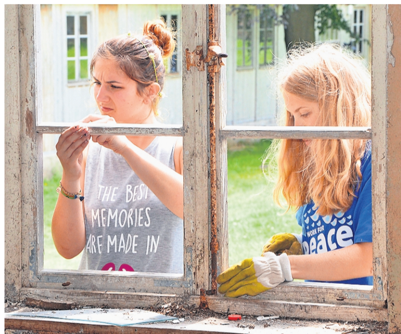
Zwei Teilnehmerinnen des Jugendworkcamps bei den Restaurierungsarbeiten an den Fenstern eines alten Latrinengebäudes.
